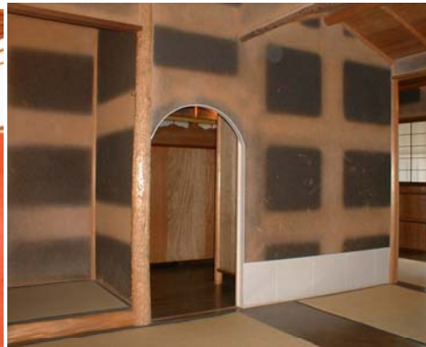
錆土の水捏ね仕上げ
