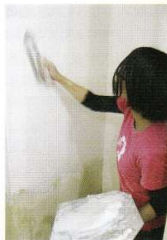
写真2 同じ現場にて漆喰仕上げ中。お施主さんに塗ってもらったあと、その鏝跡を活かしつつ仕上げている
