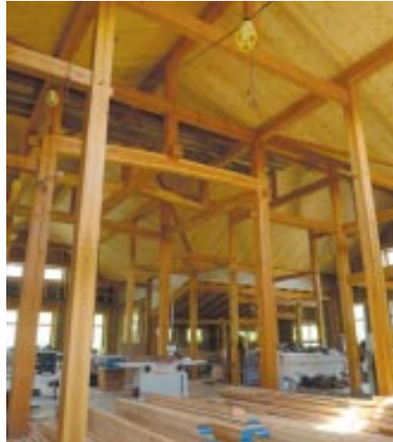
店舗予定建物内部
