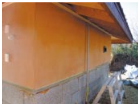
ポンプ室 / 散水により下の木材が暴れて、壁がひび割れた
