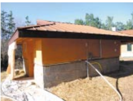
ポンプ室全景
